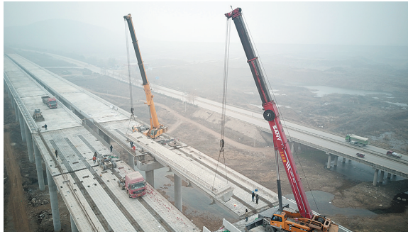
桥板安装现场
