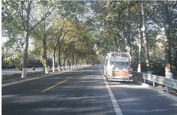
S241临徐线峰城区吴林至鲁苏界段全线贯通
