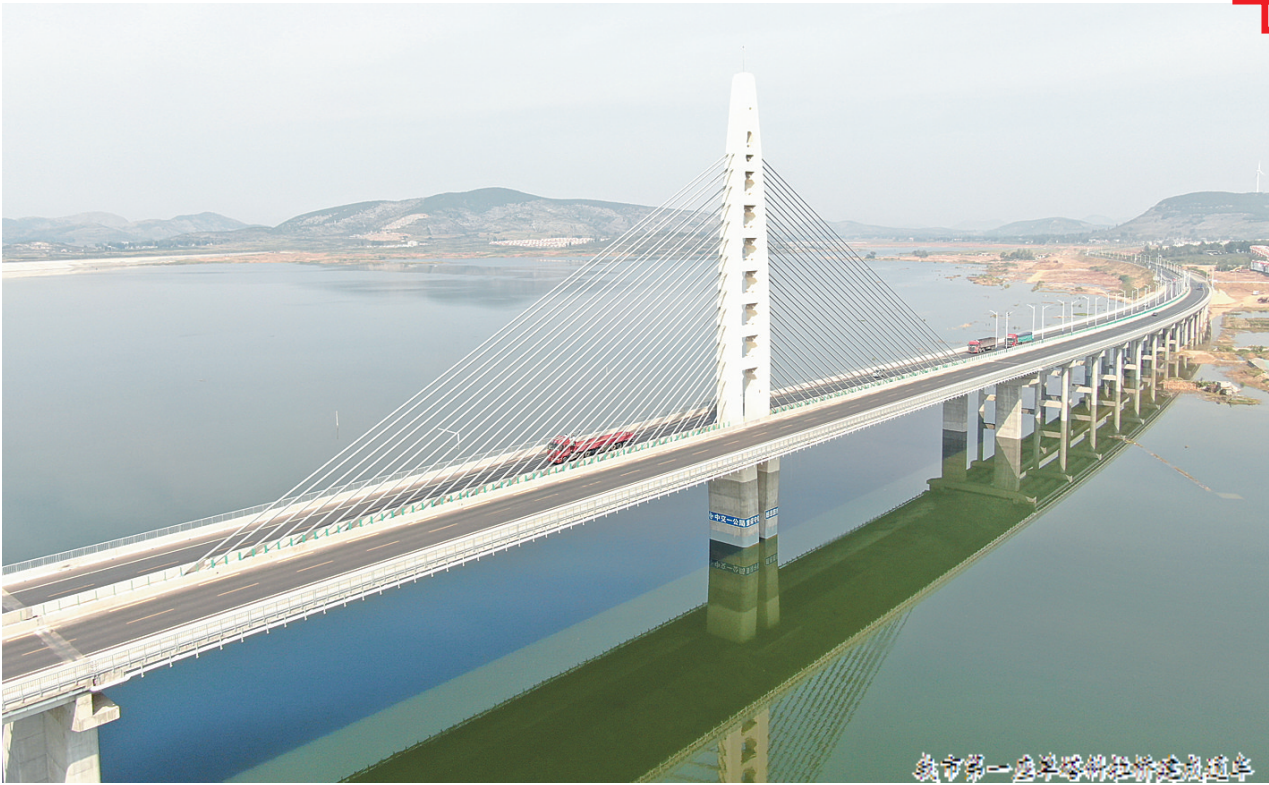
全市第一条跨海跨湖公路通车
