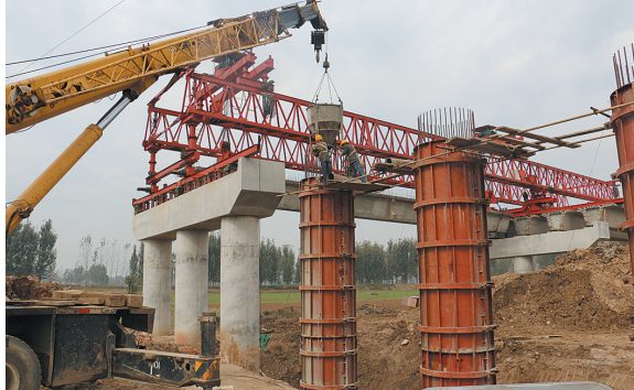
箱梁安装现场
