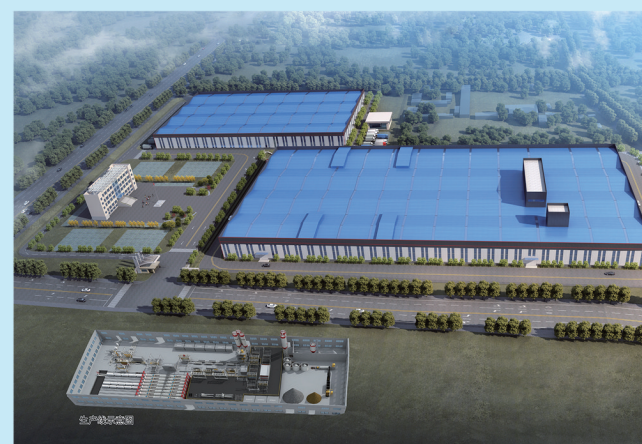
年产60万立方米绿色环保建材产业一体化建设项目（一期）正紧锣密鼓建设中
