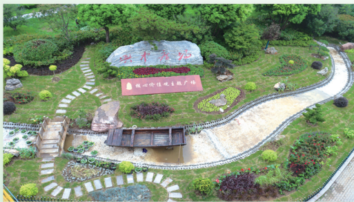
兴中广场口袋公园建设项目
