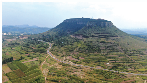
齐村镇森林防火通道建设项目
