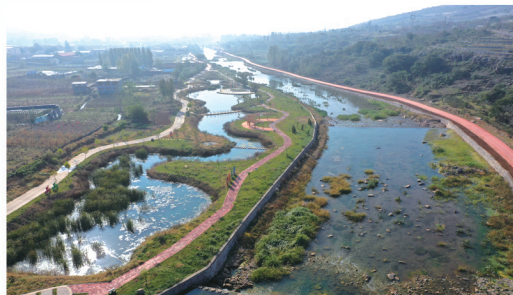
西伽河流域综合治理项目
