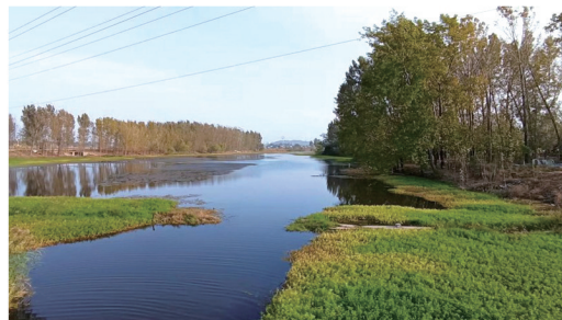
三湾里水系治理项目
