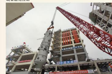
2023年4月22日，世界首台多喷嘴对置式粉煤加压气化炉，在山东能源兖矿鲁南化工有限公司起吊成功就位
