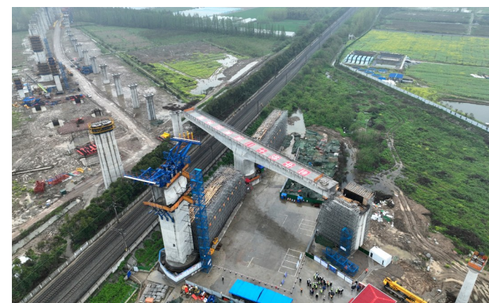
4月2日，沪渝蓉高铁武宜段汉口至汉川东下行联络线跨汉丹铁路特大桥特体完成。
