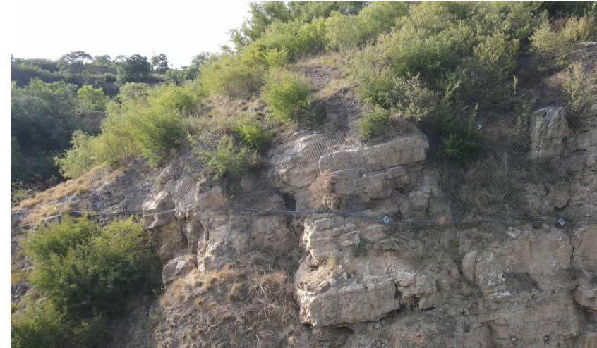
这是在山西省平陆县杜家庄段黄河岸边的古栈道上方的专业防护网(无人照照片，2024年6月17日摄)。(新华社发 权永军 摄)
