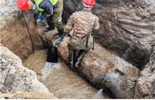
2月11日，市中区人民东路DN500管道冻裂，险情突发。区水务公司“抢修服务中心”工作人员立即到达现场进行抢修，开挖、切割、焊接、安装等工序紧张开展，一干就是5个多小时。他们冒着严寒，克服路面结冰等困难，凭借着顽强的毅力和精湛的技术，妥善解决了漏水问题，保障了居民的正常生活用水。（记者 岳娜 通讯员 夏晓民 摄）
