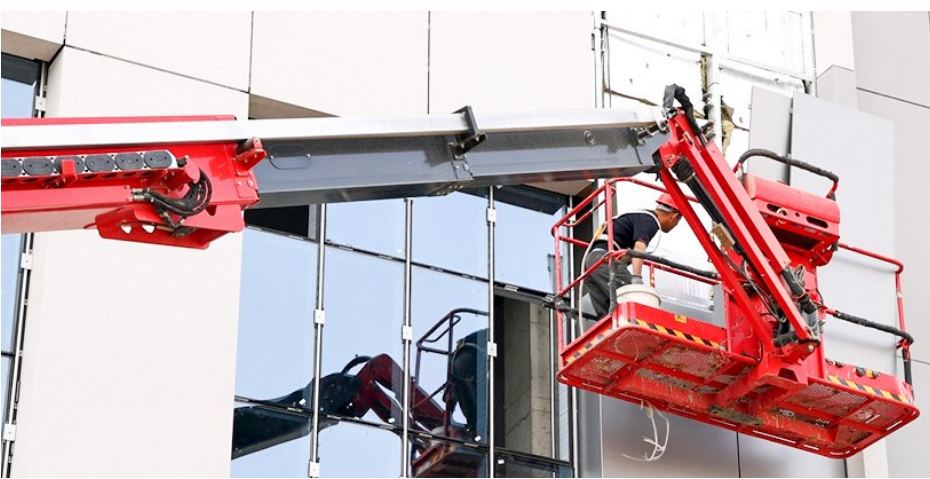
施工项目现场
