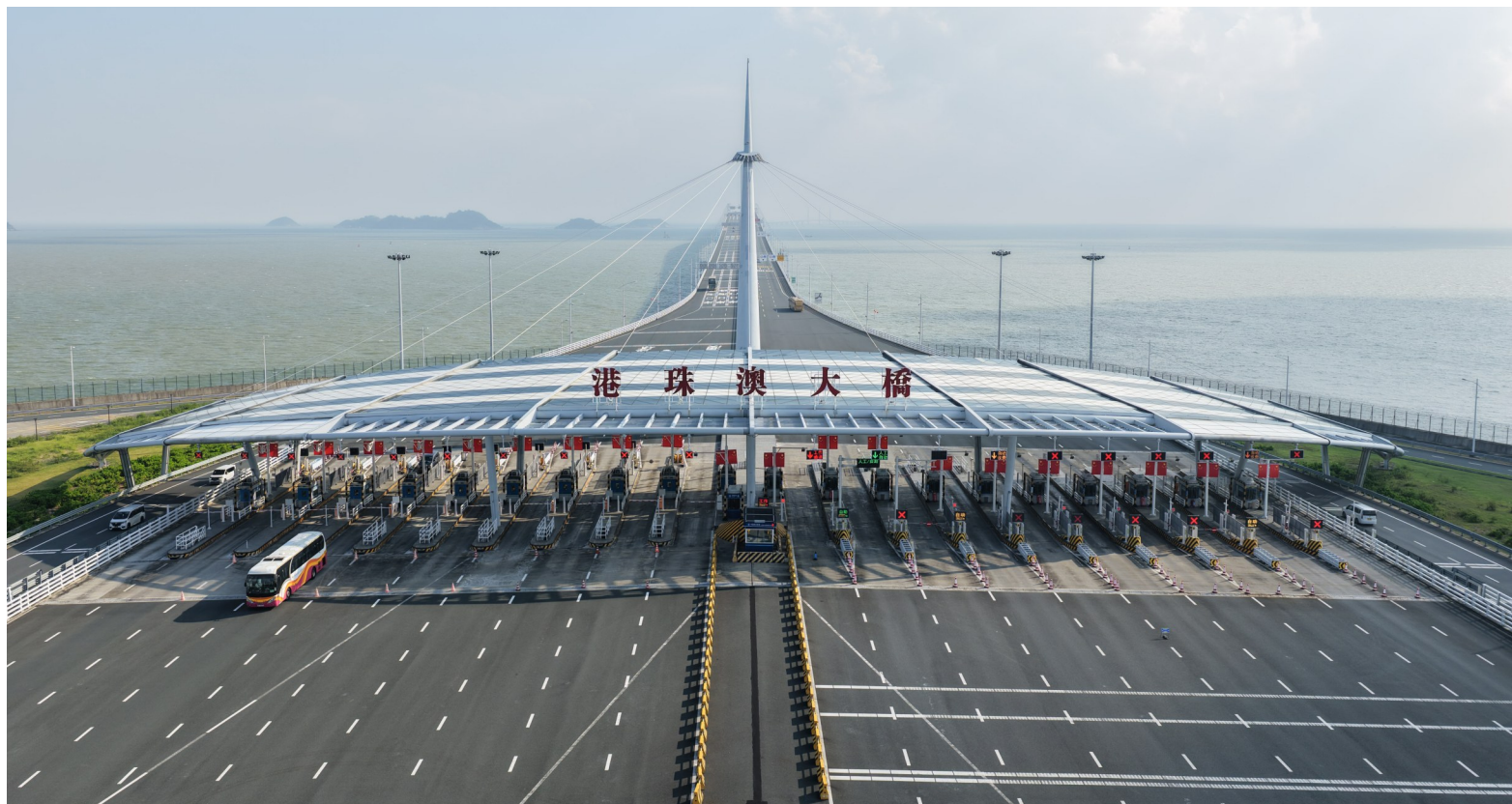
这是2025年10月19日拍摄的港珠澳大桥入口(无人机照片)。(新华社记者 邓华 摄)
