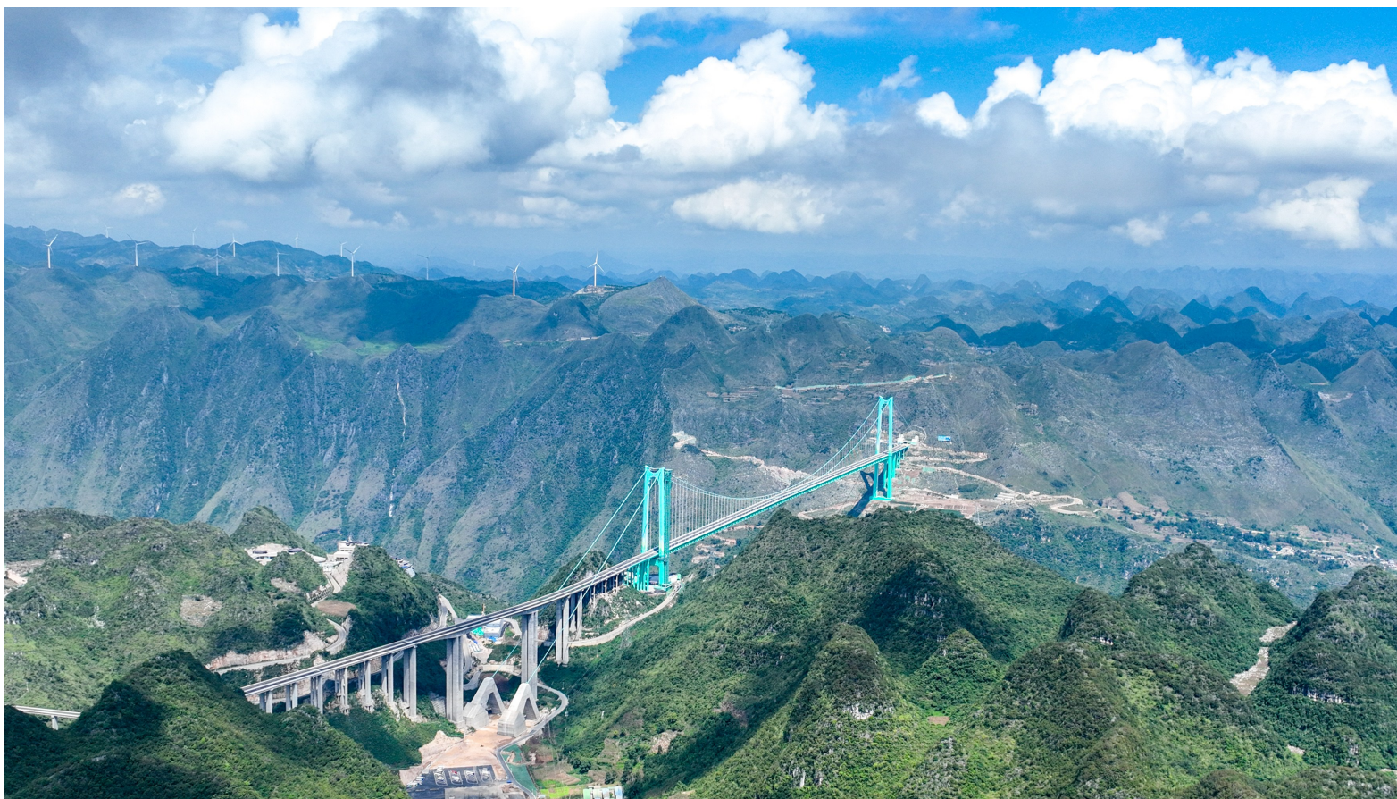
这是2025年9月28日拍摄的贵州花江峡谷大桥（无人机照片）。(新华社记者 欧东衢 摄)
