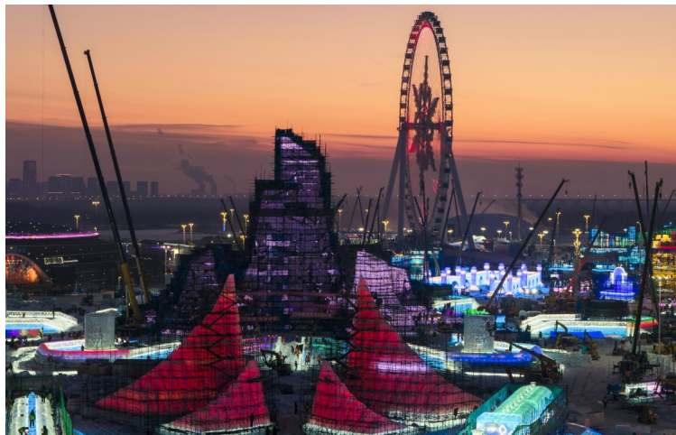
这是12月10日拍摄的哈尔滨冰雪大世界主塔施工现场（无人机照片）。12月10日，第二十七届哈尔滨冰雪大世界主塔“冰灯启梦”封顶，进入最后细节打磨和灯光调试阶段，即将惊艳亮相。据悉，主塔“冰灯启梦”总用冰量39000立方米，是本届哈尔滨冰雪大世界园区最高、单体最大的冰建景观。（新华社记者 张涛 摄）
